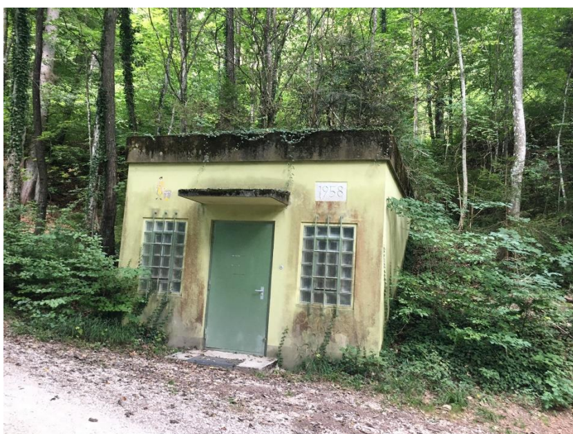
Reservoir Oberrüttenen, Baujahr 1958 (Foto 18.05.2022)
